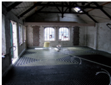
Voorbeeld van een renovatie met vloerverwarming
