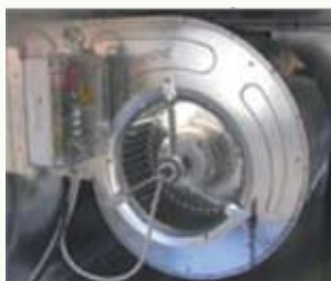
Ventilateurs à régulateurs fournis d'origine.
