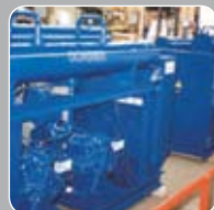
Centre de cure Vysne Ruzbacy (SK) Puissance calorifique: 419 kW Source de chaleur: l'eau
