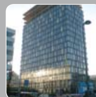
Energie AG PowerTower Linz (A) Puissance calorifique: 337,4 kW Source de chaleur : l'eau
