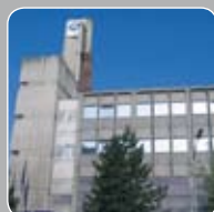
Immeuble de bureaux (A) Puissance calorifique: 90 kW Source de chaleur: eau de refroidissement
