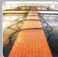
Usine hydraulique Reckov (CZ) Puissance calorifique: 111 kW Source de chaleur: l'eau
