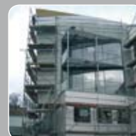
Bâtiment de l'église évangélique Commune de Bonn (D) Puissance calorifique: 2 x 113,7 kW Source de chaleur: l'eau
